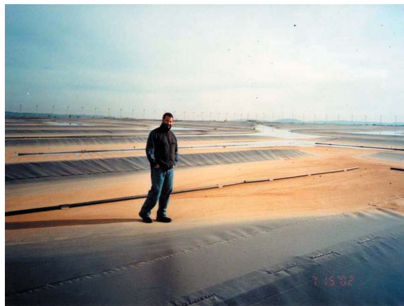
102 000 откормочных боровов, г.Корнече, Чили – Биогазовая станция с отстойной емкостью температуры окружающей среды и смешительно-отстойной емкостью (умеренный климат).
