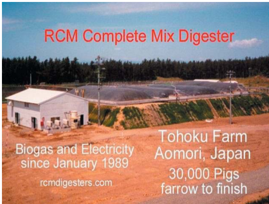
30 000 свиней и откормочных поросят. Аомори, Япония. Биогазовая станция «Complete mix», обеспечивающая тщательное перемешивание отходов (холодный климат).
