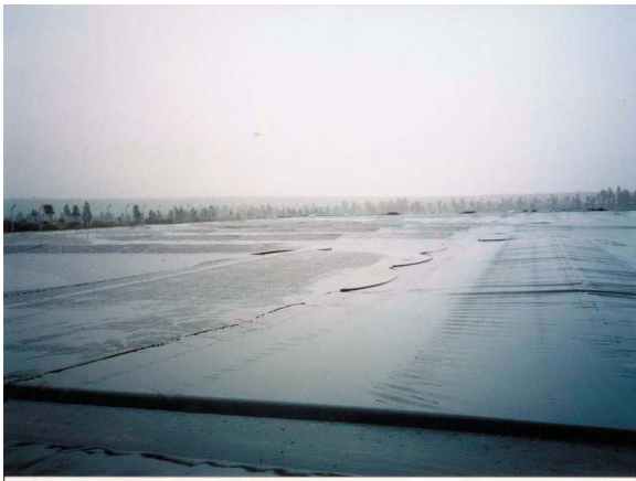
137 000 откормочных боровов, г.Ла-Эстрелья, Чили. Биогазовая станция, включающая в себя смешительно-отстойную емкость с подогревом (умеренный климат).
