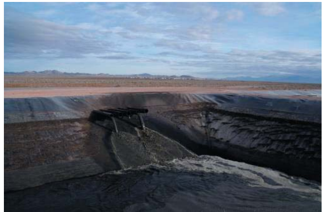
Помимо реализации упомянутых выше проектов, RCM разработала проект станции мощностью 3,2 МВт (в холодных климатических условиях), расположенной в округе Бивер, штат Юта (США). Данная биогазовая станция перерабатывает отходы свинофермы с поголовьем в 200 000. (На фото: резервуар для сбора сточных вод площадью 3 785 м 3 ).
