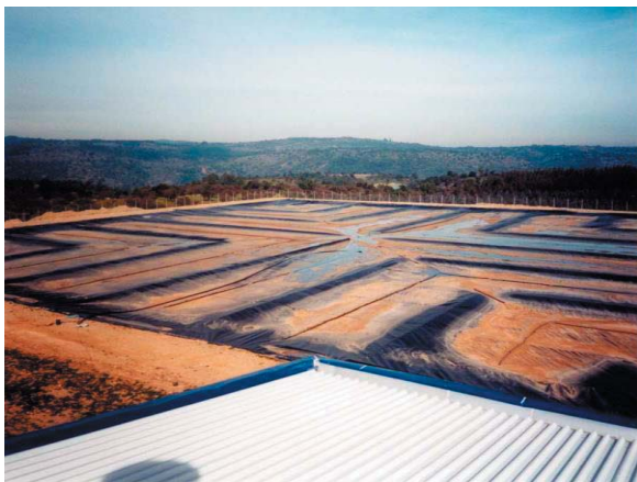
238 000 откормочных боровов, г.Порфигияс, Чили - Отпливаемая биогазовая станция (умеренный климат).
