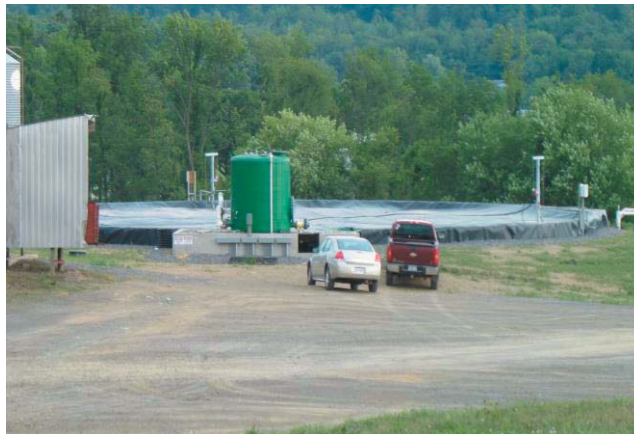
14 000 откормочного поголовья, Идеальная Ферма, Пенсильвания, США. Биогазовая станция с подогреваемой смешительно емкостью (холодный климат).
